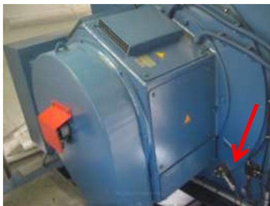
Rysunek 7. Lokalizacja czujnika z obudowie łożyska generatora
