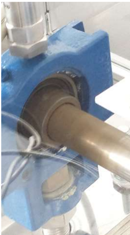
Rys. 13. Widok rzeczywistego łożyska poddanego procesowi degradacji
